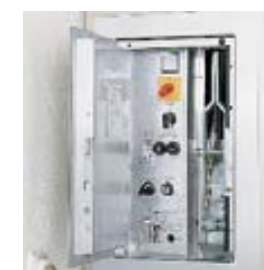
4 Панель обслуживания При помощи панели обслуживания, размещенной на верхнем этаже, технические специалисты смогут запускать процесс эвакуации в случае аварийных ситуаций, а также осуществлять диагностику.
