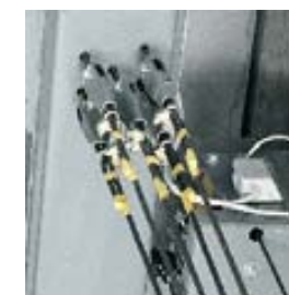
2 Крепления каната Изолированные концы канатов крепятся к приводной раме. Сама рама монтируется в нишах стен шахты.
