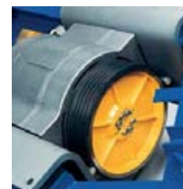
1 Привод Thyssen Mini gearless® с виброизоляцией, закреплен на раме в верхней части шахты
